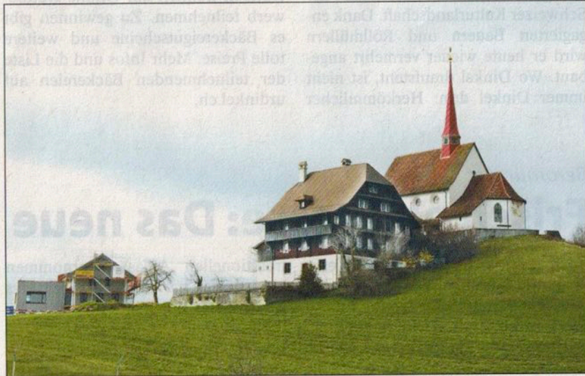
Denkmalgeschütztes Ensemble Gormund mit Kapelle, Kaplanei und Sigristenhaus. (Bild: zvg)
